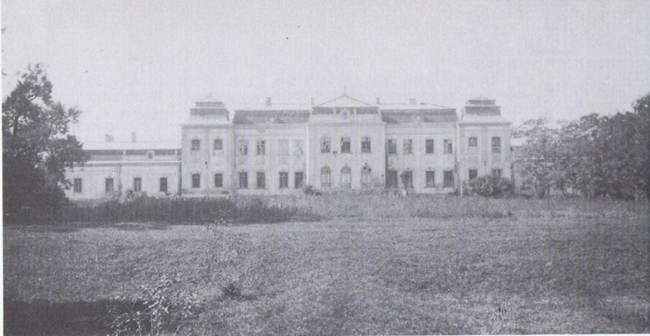
90. Krystynopol. Elewacja ogrodowa palacu, 1938 r.
