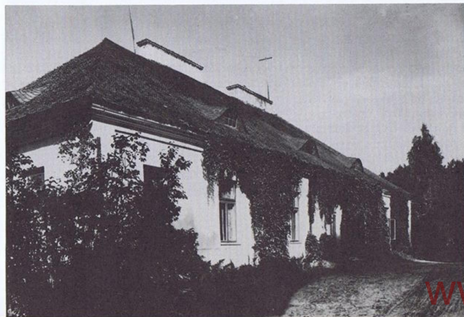
65. Krynice. Dwór od strony ogrodu, przed 1939 r.
