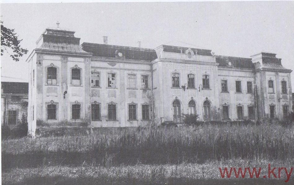
91. Krystynopol. Elewacja ogrodowa głównego korpusu palacu, 1938 r.
