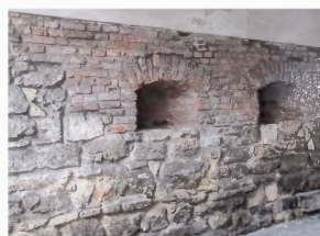
Монастир оо. Бернардинів у Львові. Внутрішні бічні першого ярусу Глинської брами (світлина авт. 2016 р.)
