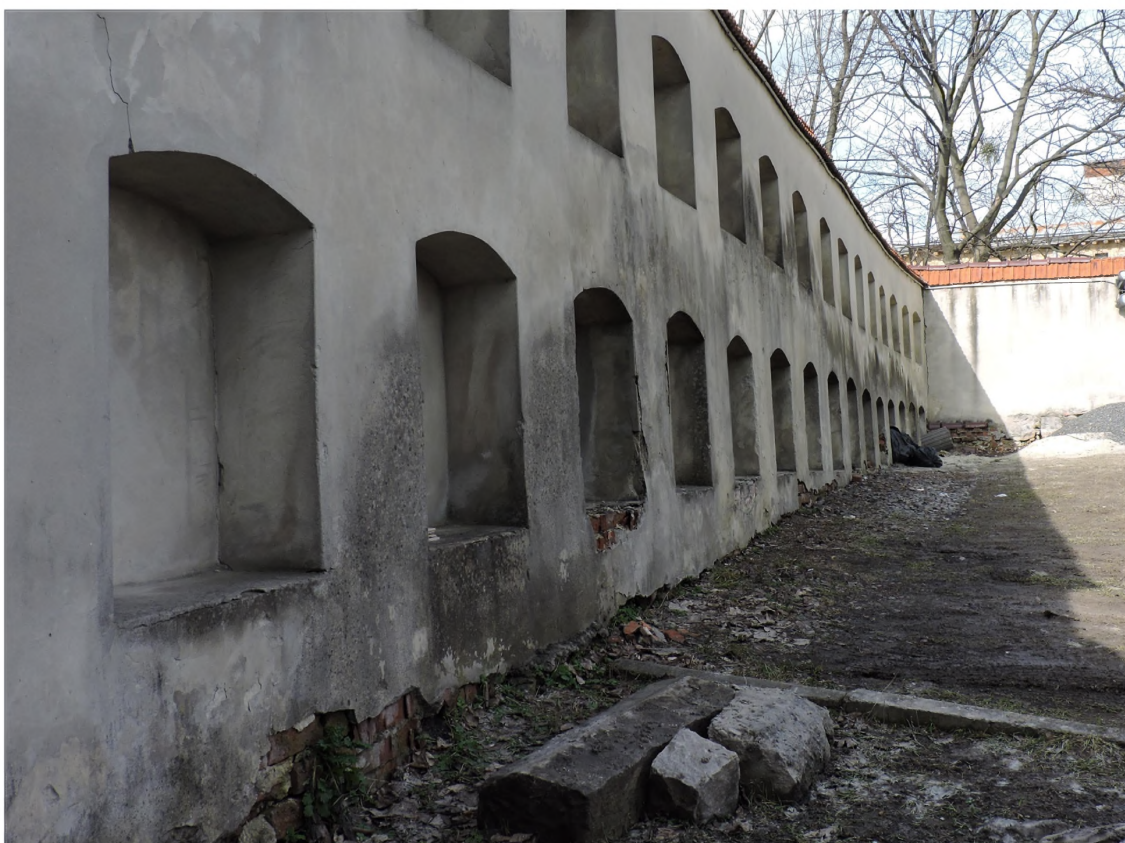
Рис.5.1.6. Фіксація стану збереження оборонних споруд монастиря оо. Кармелітів босих у Львові. Виявлено заволоження муру та відлущення тиньку XIX ст. (світлина авт. 2018 р.)
