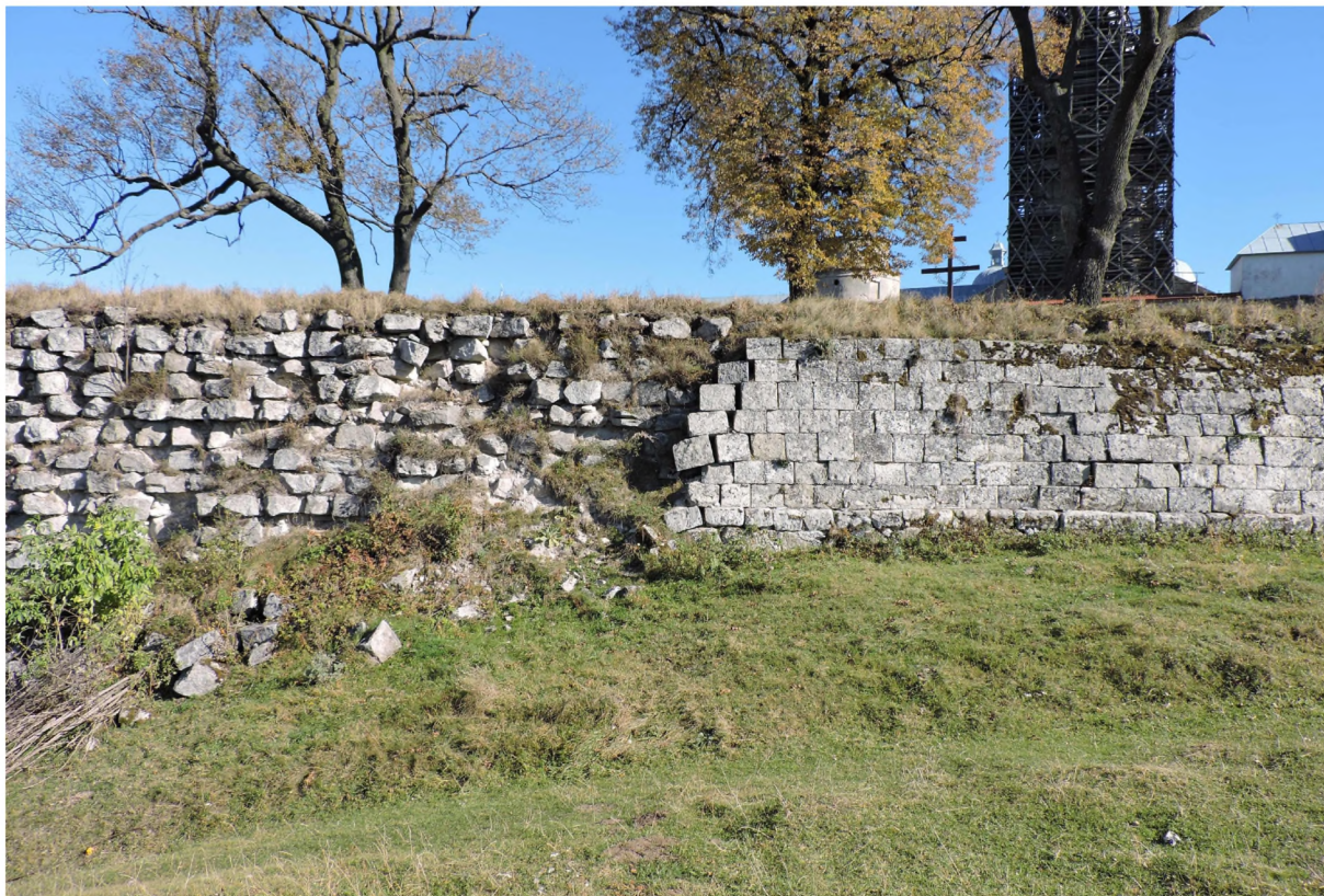
Рис.5.1.1. Фіксація стану збереження оборонних споруд монастиря оо. Домініканів у Підкамені. Оскарпування північно-західного бастиону кліщової системи (світлина авт. 2018 р.)
