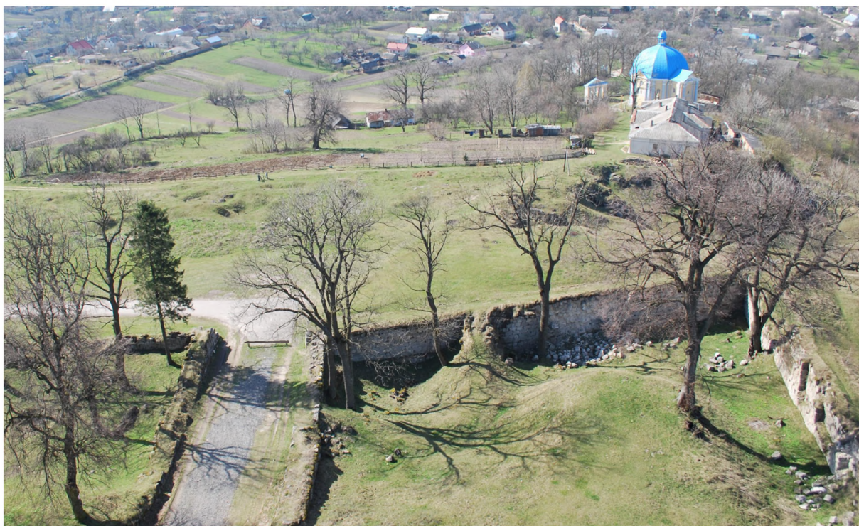
Рис.5.1.2. Фіксація стану збереження оборонних споруд монастиря оо. Домініканів у Підкамені. Вигляд на в'їздний оборонний вузол з вежі костелу (світлина авт. 2014 р.)
